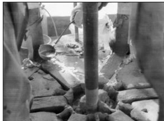
Vergießen der Zuganker im Glockenaufsatz mit Blei
