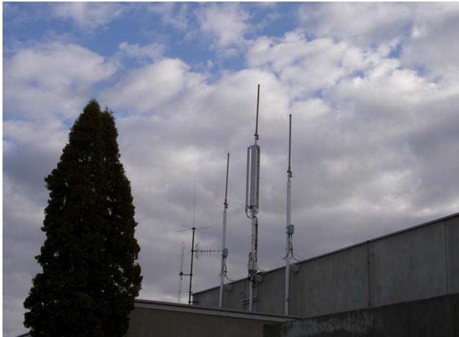
Abbildung 4: Mobilfunkbasisstation auf der Frankenhalle (Detailansicht – Standort A)
