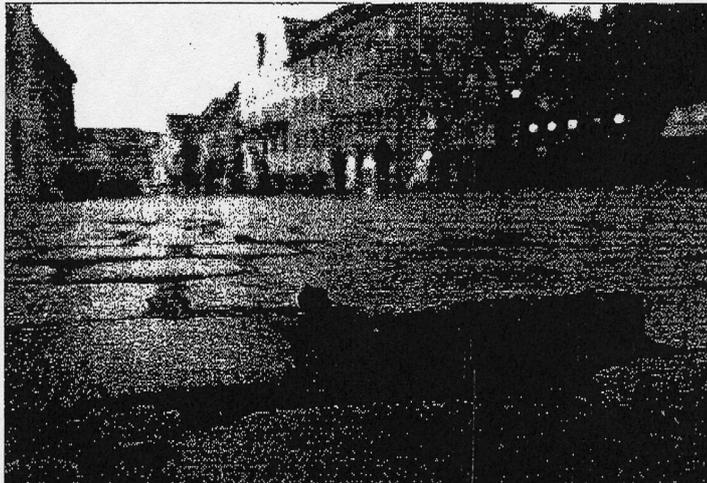
Wie Pilze schießen die Pflastersteine in Nürnbergs Innenstadt aus dem Boden. Der Grund: Statt Bitumen wurde Zement verwendet, und der hält die Belastung nicht aus. Fotos: Gerullis
