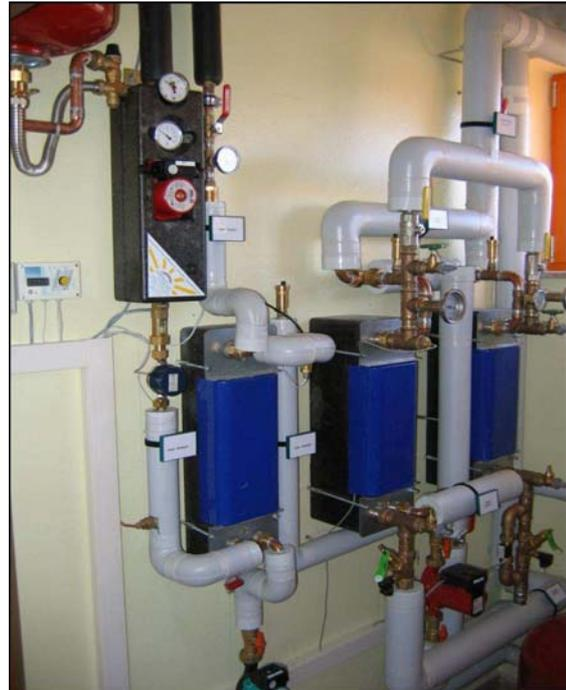
Solarübergabestation mit Plattenwärmetauscher
