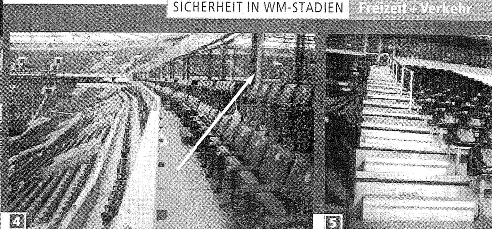
**Bild 4:** Häufig fehlt ein zweiter Fluchtweg von den Logentribünen (hier Veltins-Arena). **Bild 5:** Unregelmäßige Stufen wie hier in Dortmund laden geradezu zum Stolpern ein.
