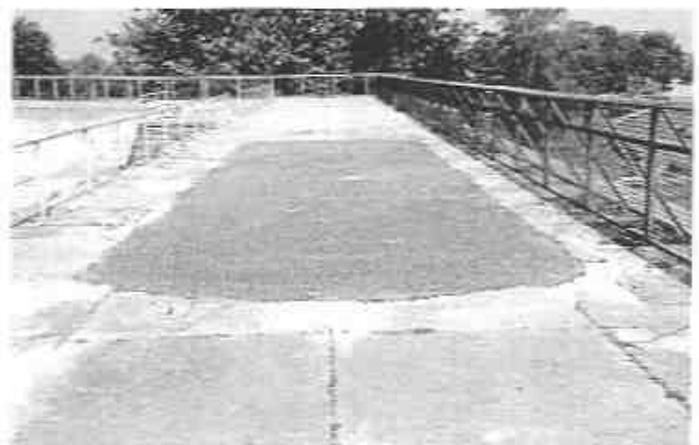
Situation 2007, Treppenzugänge mit Betonplatten verschlossen
