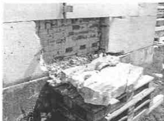
Abgebaute Steinplatte mit dahinter liegender Ziegelausmauerung
