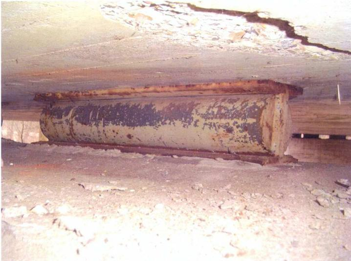
Bild 5939 – Ausbruch über Pfeiler Achse 4 links
