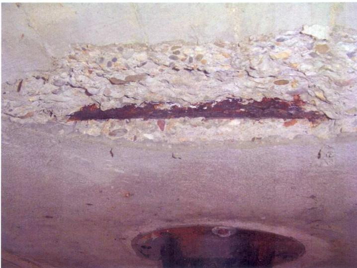
Bild 5970 – Ausbruch mit freiliegender, korrodierter Tragbewehrung im Feld rechts
