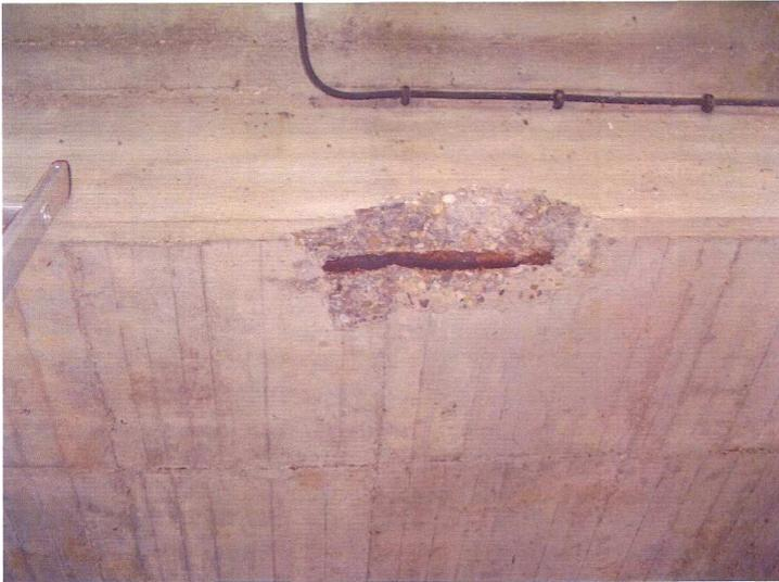
Bild 5971 – Ausbruch mit freiliegender, korrodierter Tragbewehrung im Feld links
