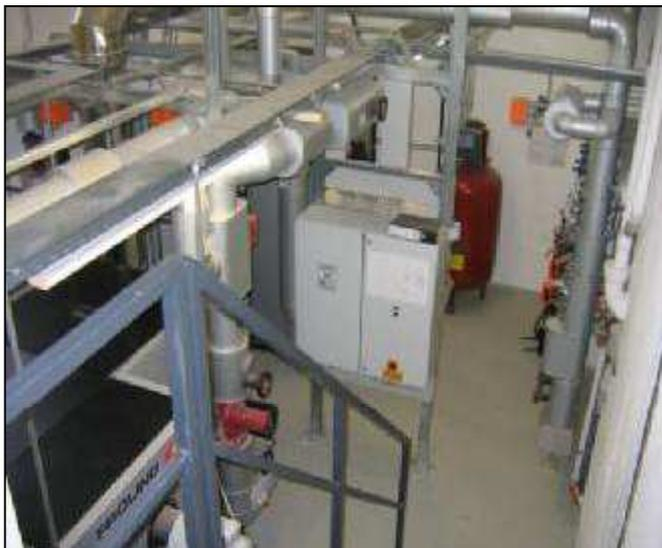
Bild 5: Heizzentrale des Verwaltungsgebäudes nachher: Pelletskesselanlage mit Pufferspeicher und Verrohrung.
