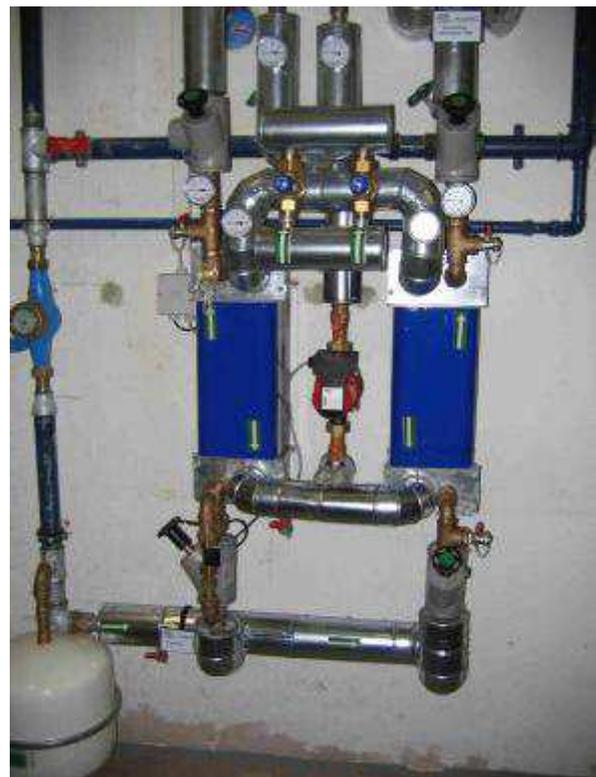
Bild 3: Hochleistungswärmetauscher der Frischwasserstation
