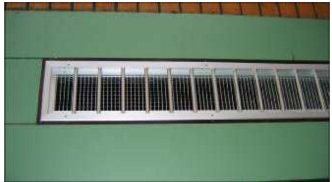
Bild 6: Neu: Selbsttätig verstellendes Zuluftgitter, ballwurfsicher
