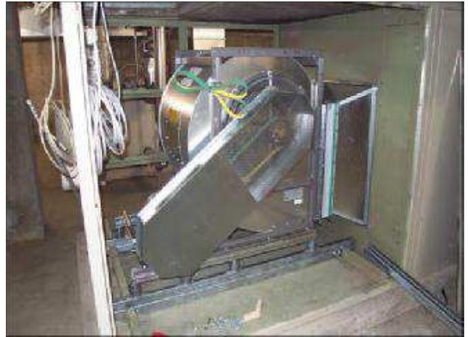
Bild 2: Neu montierter Abluftventilator Sporthalle; ausgestattet mit rückwärts gekrümmten Schaufelrad, Flachriemenantrieb und Motor für Betrieb mit stufenloser Frequenzumformersteuerung.
