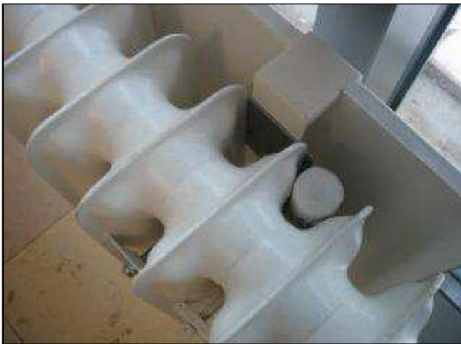
Bild 2: Handwerklich gefertigter Blech-Strahlungsschirm vor erneuerter Fassade des Sigena-Gymnasiums
