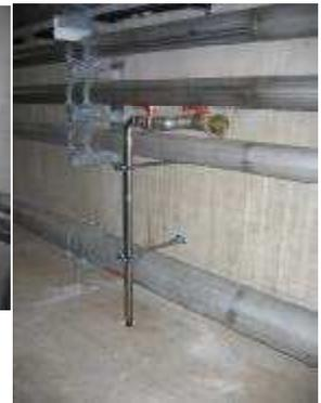
Bild 5: Anbindung an Betriebswasserleitung
