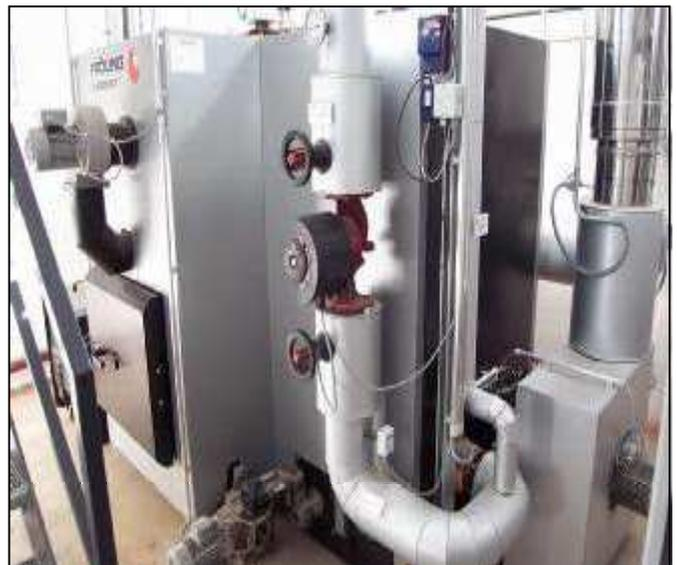
Bild 2: Die Holzpelletskesselanlage mit Brennkammer, Wärmetauscher und Kesselpumpe.
