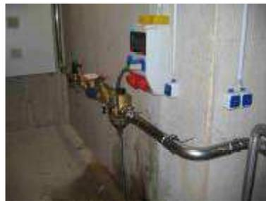
Bild 4: Wasserzählergruppe mit Filter
