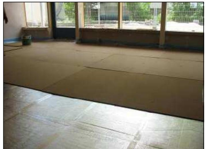
Bild 5: Einbau von Vakuum-Dämmung
