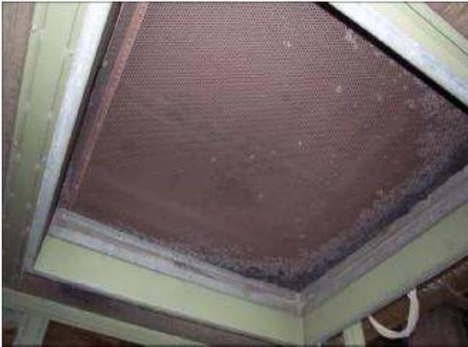
Bild 3: Mittlerweile ausgebaut: Lochblechgitter zur Luftmengenreduzierung.
