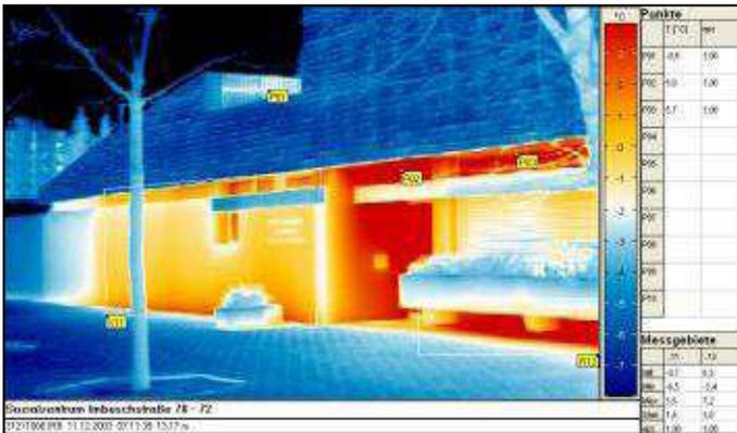
Bild 3: Wärmebild Südfassade vor der Sanierung
