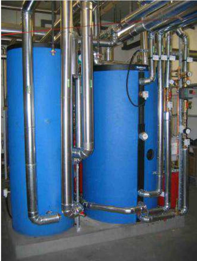
Bild 2: Warmwasserspeicher, Pufferspeicher und Solarkreisstation
