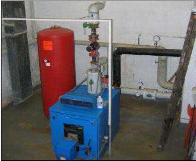
Bild 4: Heizzentrale des Verwaltungsgebäudes vorher: Ölkesselanlage mit dem Heizkreis „Heizkörper Verwaltung“.
