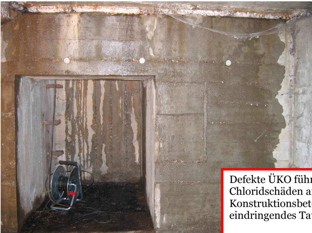
Defekte ÜKO führt zu Chloridschäden am Konstruktionsbeton durch eindringendes Tausalzwasser.
