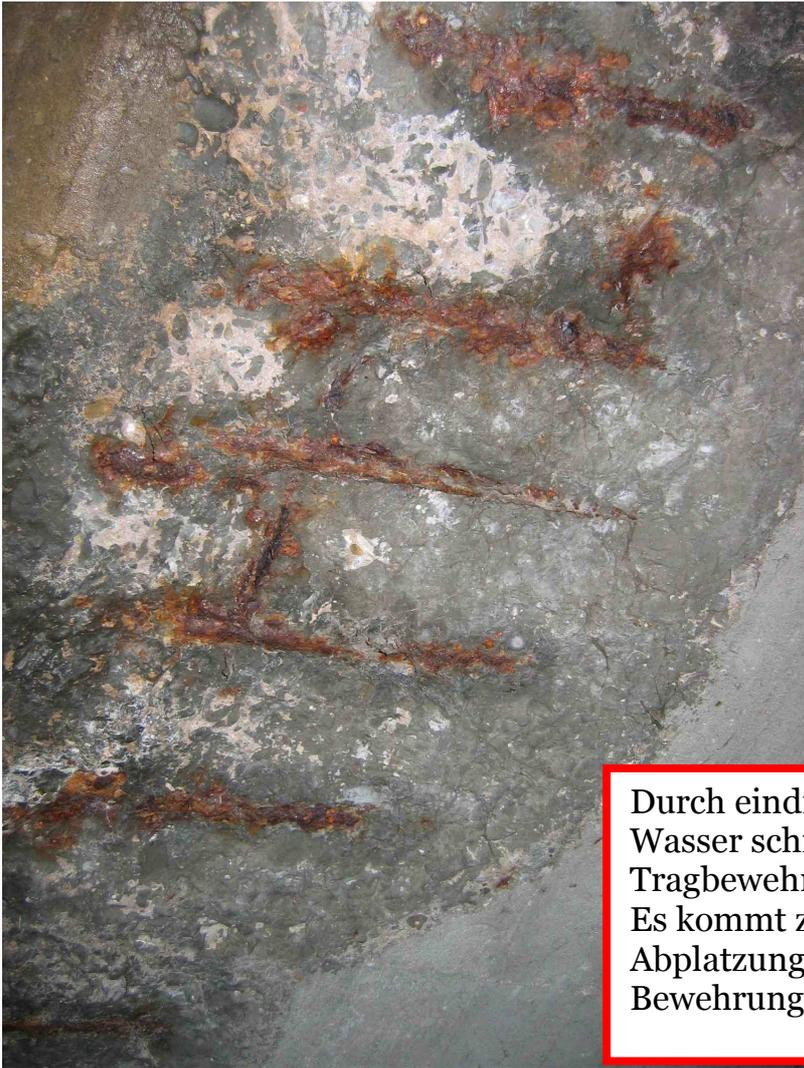
Durch eindringendes chloridhaltiges Wasser schreitet die Korrosion der Tragbewehrung immer weiter voran. Es kommt zu großflächigen Abplatzungen über korrodierten Bewehrungsstäben.
