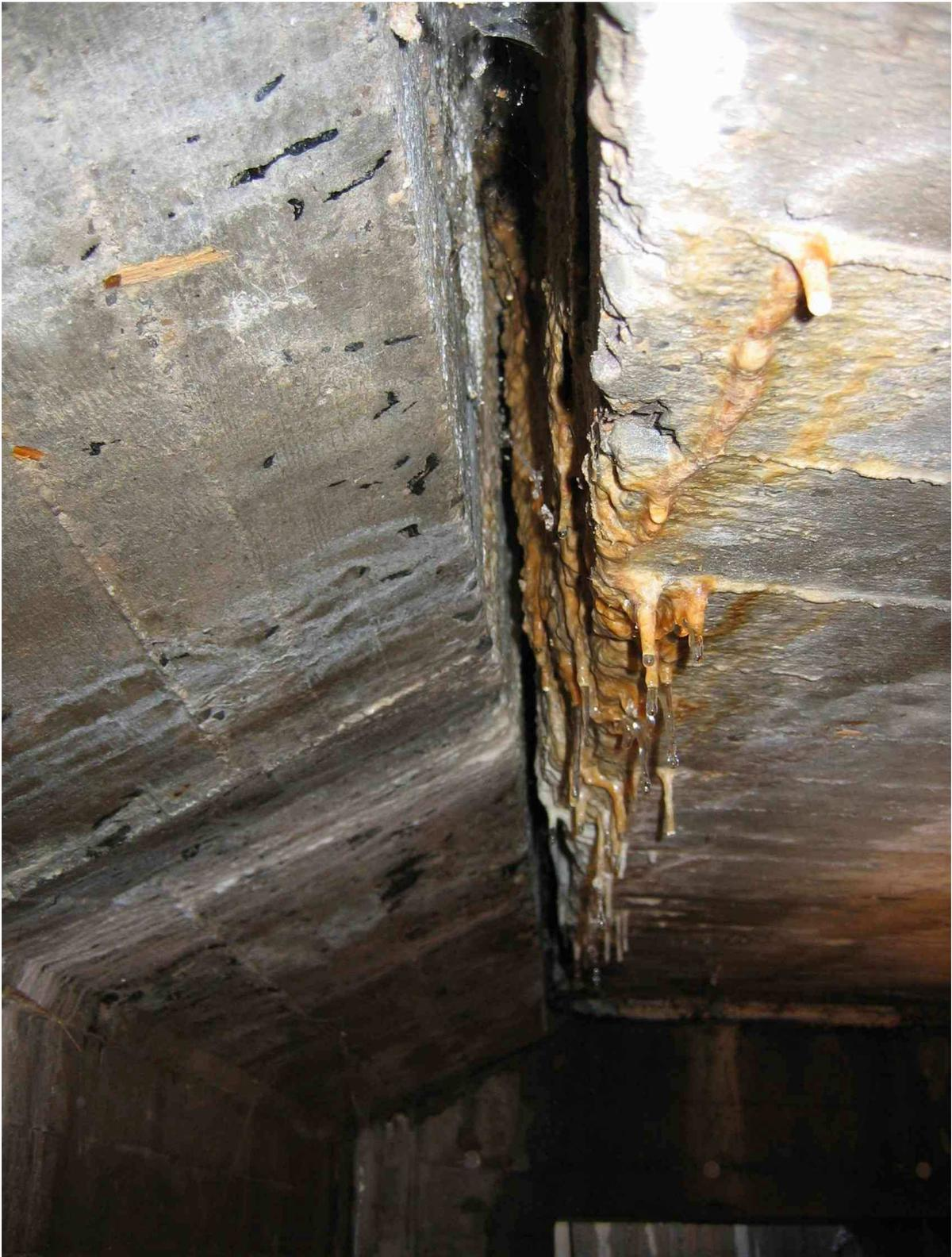
Defekte ÜKO führt zu Chloridschäden am Konstruktionsbeton durch eindringendes Tausalzwasser.
