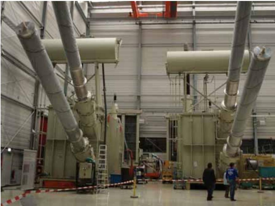
Endmontagehalle mit 800 KV HGÜ-Transformatoren
