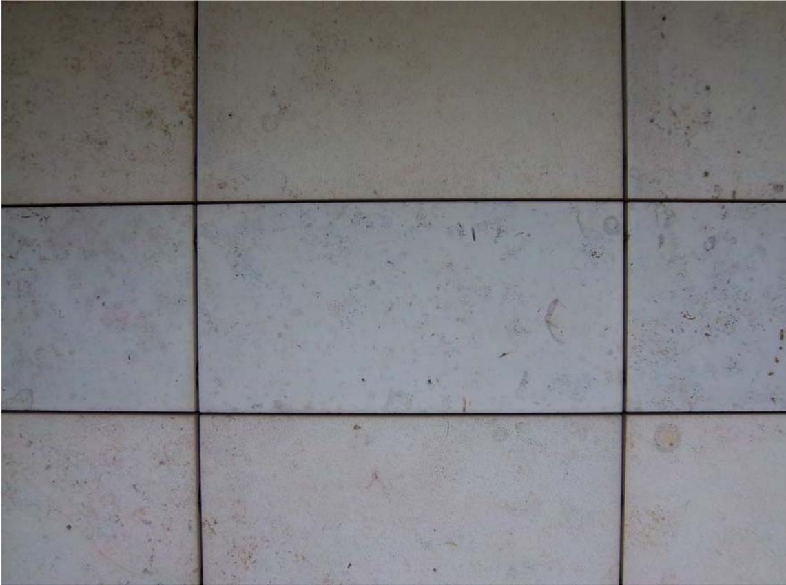
**Abbildung 2: Verblendung der Fassade mit Steinplatten und dazwischen liegenden Fugen**
