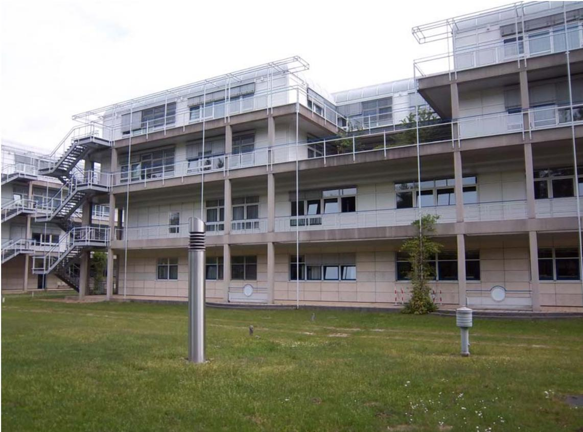
**Abbildung 3: Blick auf die nordwestliche Fassade des Klinikgebäudes. Deutlich zu sehen ist die unterschiedliche Fassadenausbildung (Steinplatten, Metall) von Erdgeschoss und Obergeschossen**
