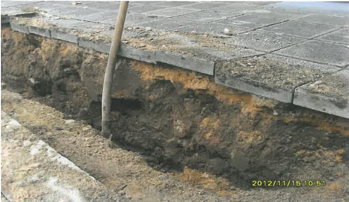
**Bild 2** Gehweg mit Regelunterbau
