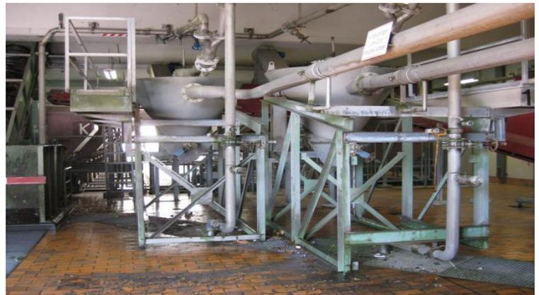
Kläranlage Wien – Sandklassierer (Sand- und Wasserabscheidung), Mechanische Reinigung
