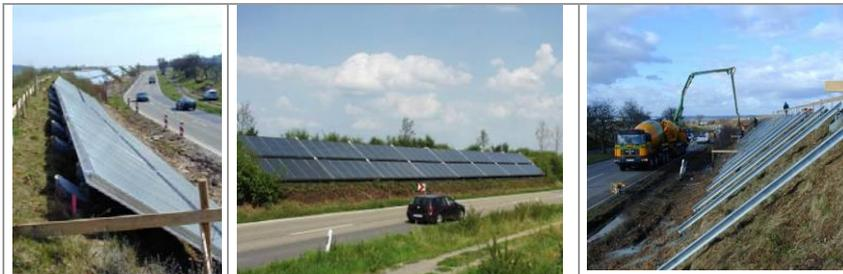
Bild 13: Aufstellung von Kollektoren auf einem Lärmschutzwall
