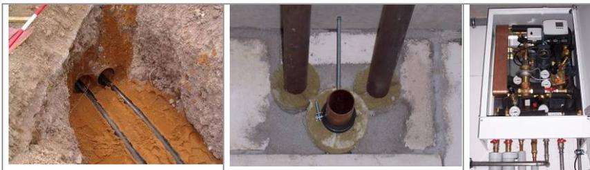
Bild 10: Wärmenetz mit PEX-Rohr, Verbindung zwischen 2 RH, Kompakt-Übergabestation
