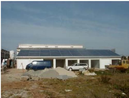
Bild 9: Anordnung von Kollektoren auf einer Garagenzeile
