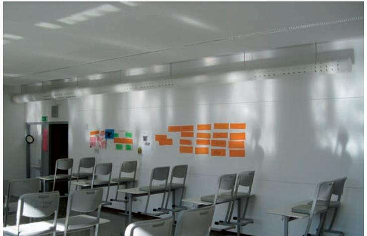
*Nachträglich eingebaute Lüftungsanlage im Neuen Gymnasium Nürnberg (NGN)*
