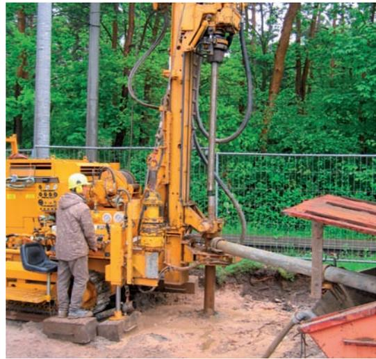
*Bohrung einer Erdsonde für das Objekt Trierer Straße*
