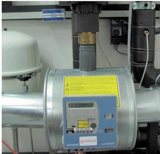
Beispiel für einen Wärmemengenzähler für Fernwärme
