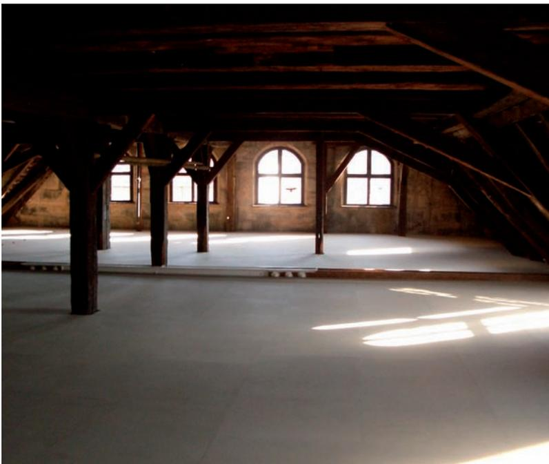
*Dämmung der obersten Geschossdecke in der Unteren Talgasse 8*
