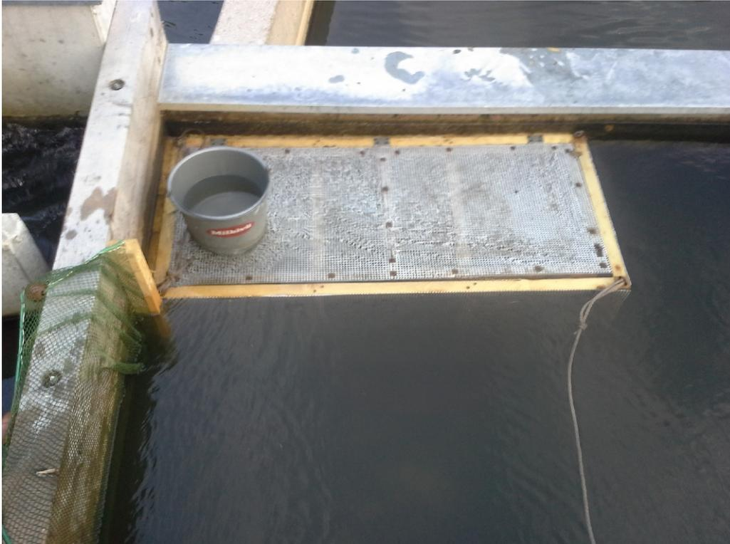
*Abbildung 6: Reusenkasten im Fischpass Hammer.*
