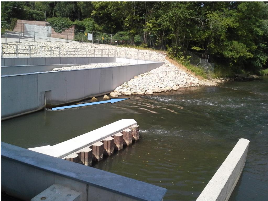
*Abbildung 2: Anbindung der Fischwanderhilfe an den Hauptwanderkorridor aus dem Unterwasser.*
