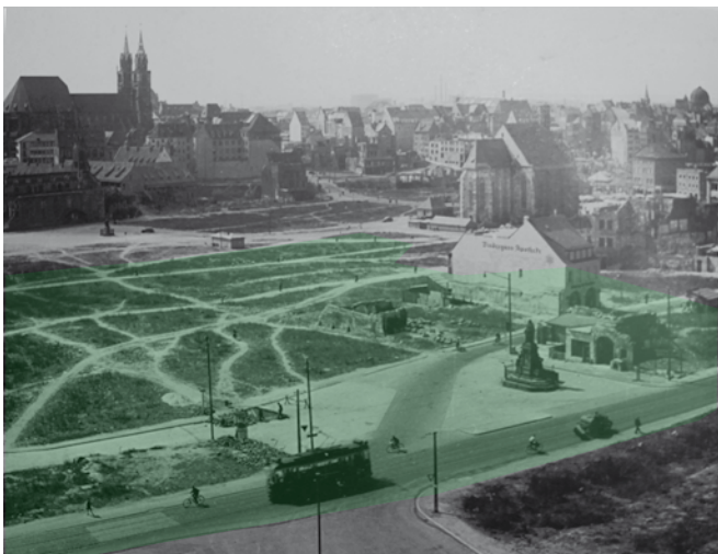
„Sebalder Steppe 1947 - Blick von der Egidienkirche nach Süden
