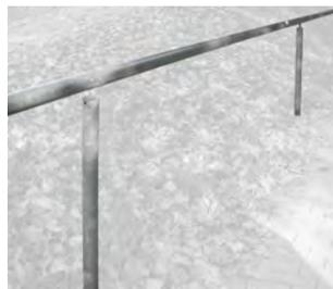
Handlauf aus Stahl, Rundrohr 50 mm, feuerverzinkt
