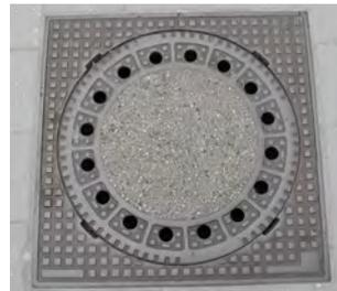
Schachtabdeckung, eckig, Gusseisen mit Betonguss
