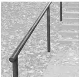
Handlauf aus Stahl, Rundrohr 50 mm
