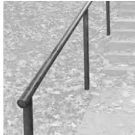
Handlauf aus Stahl, Rundrohr 50 mm
