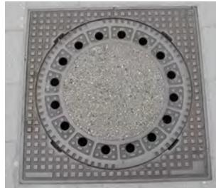
Schachtabdeckung, eckig, Gusseisen mit Betonguss
