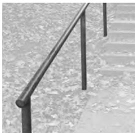
Handlauf aus Stahl, Rundrohr 50 mm
