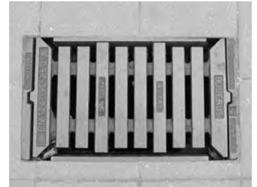
Straßeneinlauf eckig, Gusseisen 300 x 500 mm nach DIN 19594 oder 500 x 500 mm nach DIN 19571 bzw. DIN 19583
