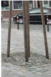
Gepflasterte Baumscheibe mit Gießrand aus Granit- oder Kalkschotter,  $\leq 1 \text{ m}^2$
