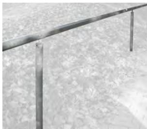
Handlauf aus Stahl, Rundrohr 50 mm, feuerverzinkt
