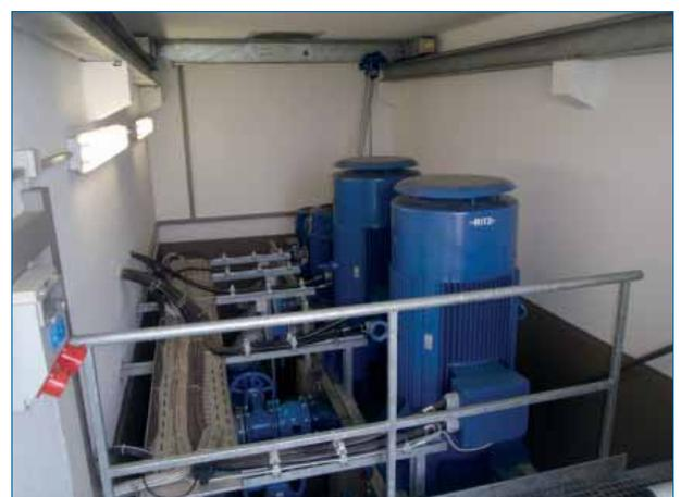
Abbildung 24: Beregnungspumpwerk und Brunnenfassung (Quelle: Wasserverband Knoblauchsland)
