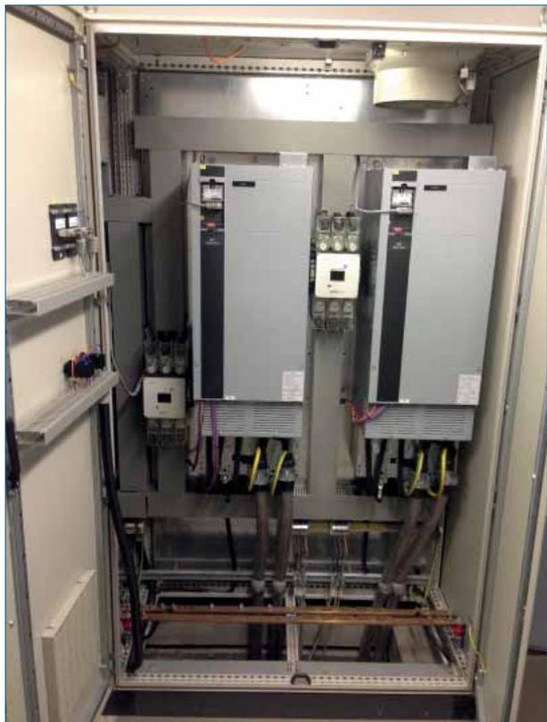
Abbildung 29: Schaltanlage mit Frequenzumrichter
