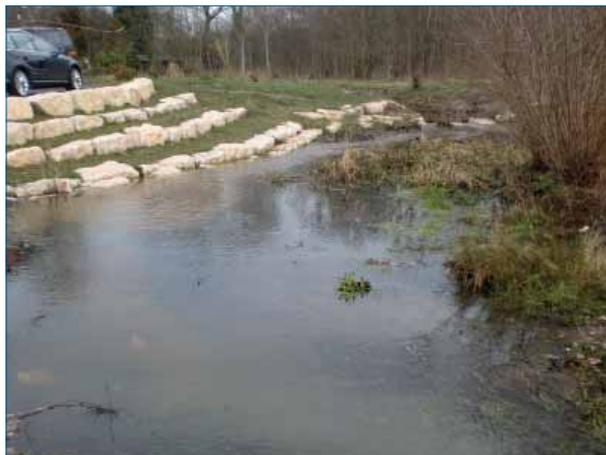
Abbildung 3: Maßnahmen zur Hochwasserfreilegung Ziegelstein, hier: aufgeweiteter und renaturierter Bereich des ehemaligen Rübenweiher (Teilstück des Hirschsprunggrabens) mit Uferbefestigung als Sitzgruppe (Quelle: Stadt Nürnberg, Service Öffentlicher Raum / Brückenbau und Wasserwirtschaft)
