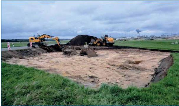
Abbildung 109: Löschbecken West – Pilotversuch Bodenaustausch (Quelle: albuCon GmbH)
