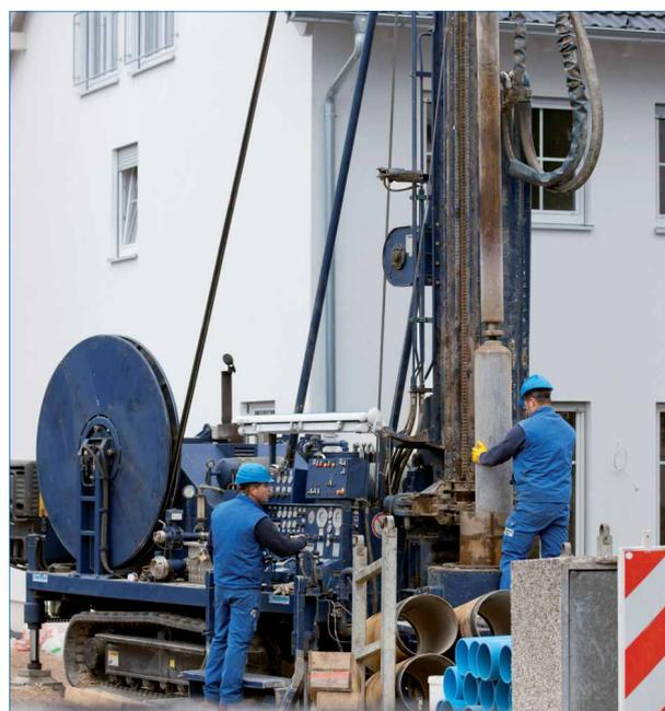
Abbildung 81: Durchführung einer Brunnenbohrung im Wohnungsbau
