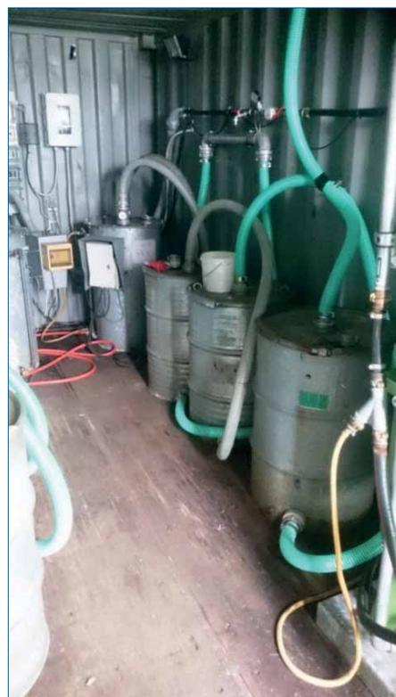
Abbildung 120: Aktivkohle-Reinigungsanlage einer Bodenluftabsaugung (Quelle: Stadt Nürnberg, Umweltamt)
