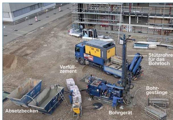
Abbildung 80: Herstellung einer Erdwärmesondenanlage im Gewerbebau
