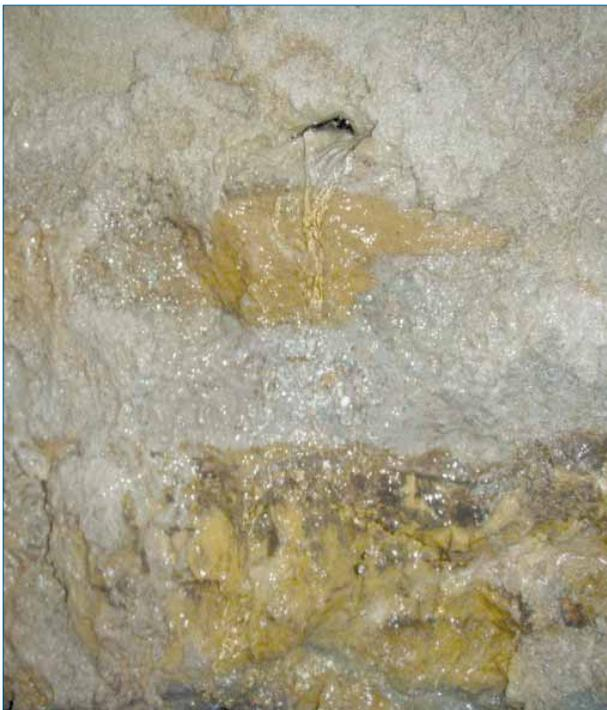
Abbildung 38: Wasseraustritt über „Quacken“horizont aus Klüften im Blasensandstein (U-Bahnbau Nürnberg / bergmännischer Vortrieb) (Foto: TÜV Rheinland LGA Bautechnik GmbH)
