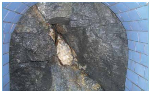
Abbildung 32: Typischer Muschelkalk-Aquifer: Starker Wasseraustritt aus verkarsteter Störungsfläche mit Klufftüllung; Norbertusheim-Stollen der Trinkwasserversorgung Würzburg. (Foto: BAIER, GeoZentrum Nordbayern der FAU Erlangen-Nürnberg).
