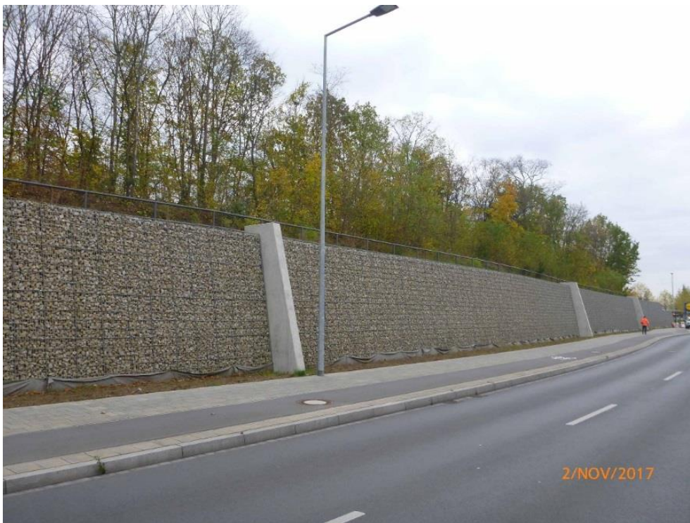
Bild: Gabionenstützwand Erlanger Straße (stadtauswärtige Fahrtrichtung)
