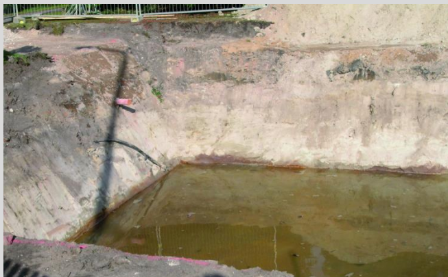
Baugrube mit Wasser
