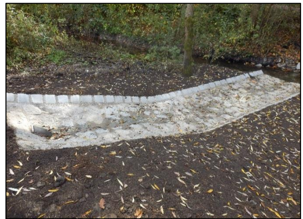
Bild 2: Einleitungsbauwerk Bucher Landgraben
