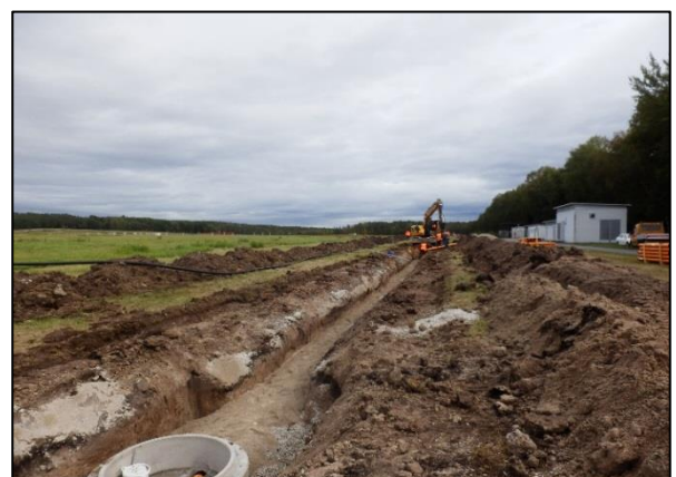
Bild 4: Erdarbeiten Freispiegelleitung
