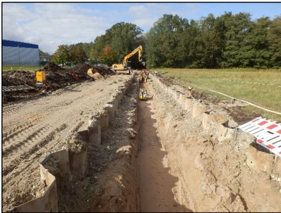
Bild 1: Rigolenbau innerhalb Spundwand
