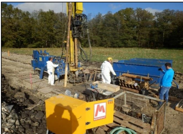
Bild 3: Bohrarbeiten Brunnenbau
