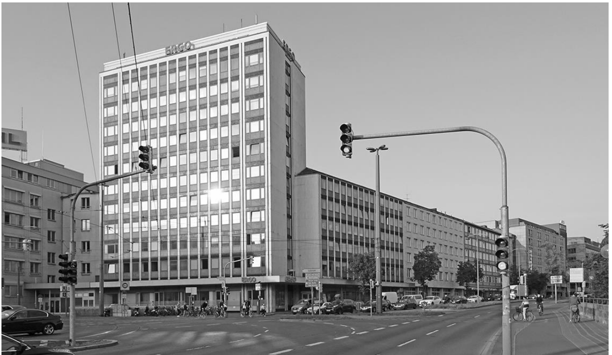
Ergo Hochhaus heute vom Bahnhofplatz aus gesehen, Traufhöhe ca. 40 m
