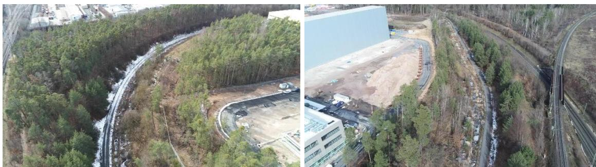
*eigene Aufnahmen (Kameradrohne): westliches Gleis der ehemaligen Bahntrasse durch Erdarbeiten unterschiedlich gestaltet, im östlichen Gleisbett Bahnschotter vollständig vorhanden, B öschungen stark verbuscht bzw. teilweise bereits bewaldet*
