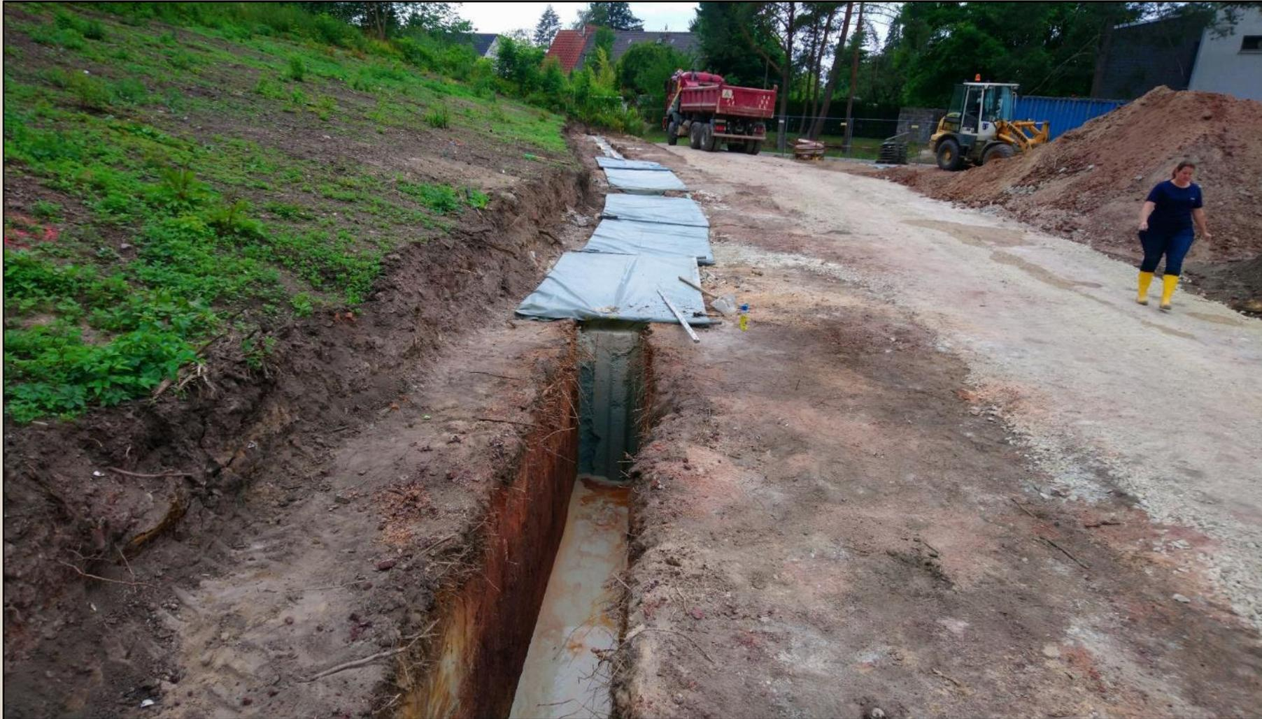
Lückenschluss einer Lamelle (Dichtwandsuspension verfestigt)
