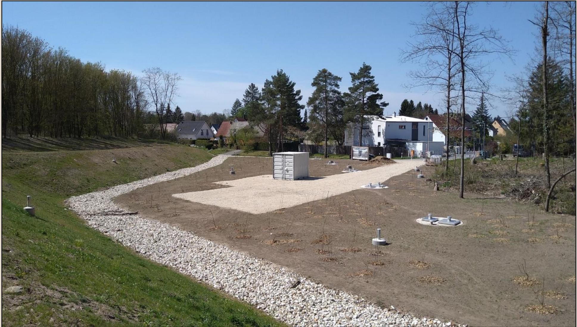
Abgedichtete Böschung - Rigole - Reinigungsanlage - Sanierungsbrunnen
