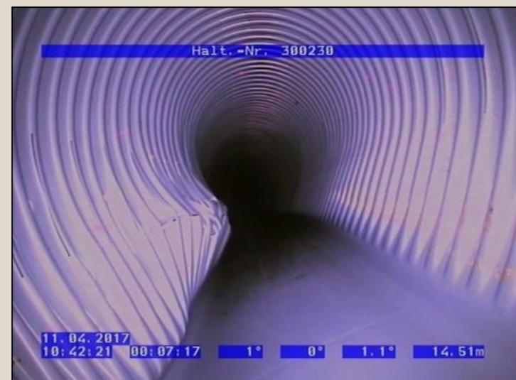
Deformiertes Drainagerohr mit starker plastischer bzw. bruchhafter Verformung
