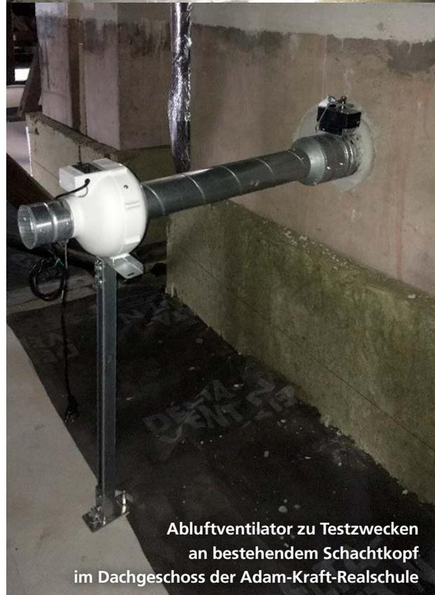
Abluftventilator zu Testzwecken an bestehendem Schachtkopf im Dachgeschoss der Adam-Kraft-Realschule
