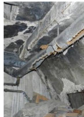
*Korrosionsschäden, Regenwasserleitung und Wände über Glucksaal*
