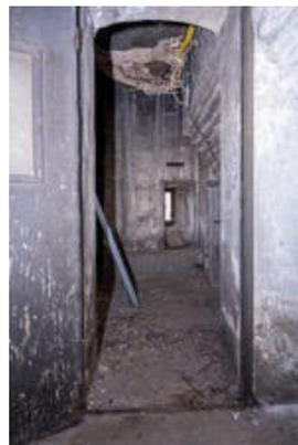
*Wasser-/Korrosionsschäden im Hauptdach am Bühnenturm*
