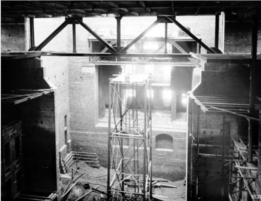
Abbildung 15: Blick in den Rohbau des Bühnenturms bei Errichtung 1904. Deutlich sichtbar ist das Mauerwerk des Bühnenturms sowie die Trägerkonstruktionen über Portal und Hinterbühne
