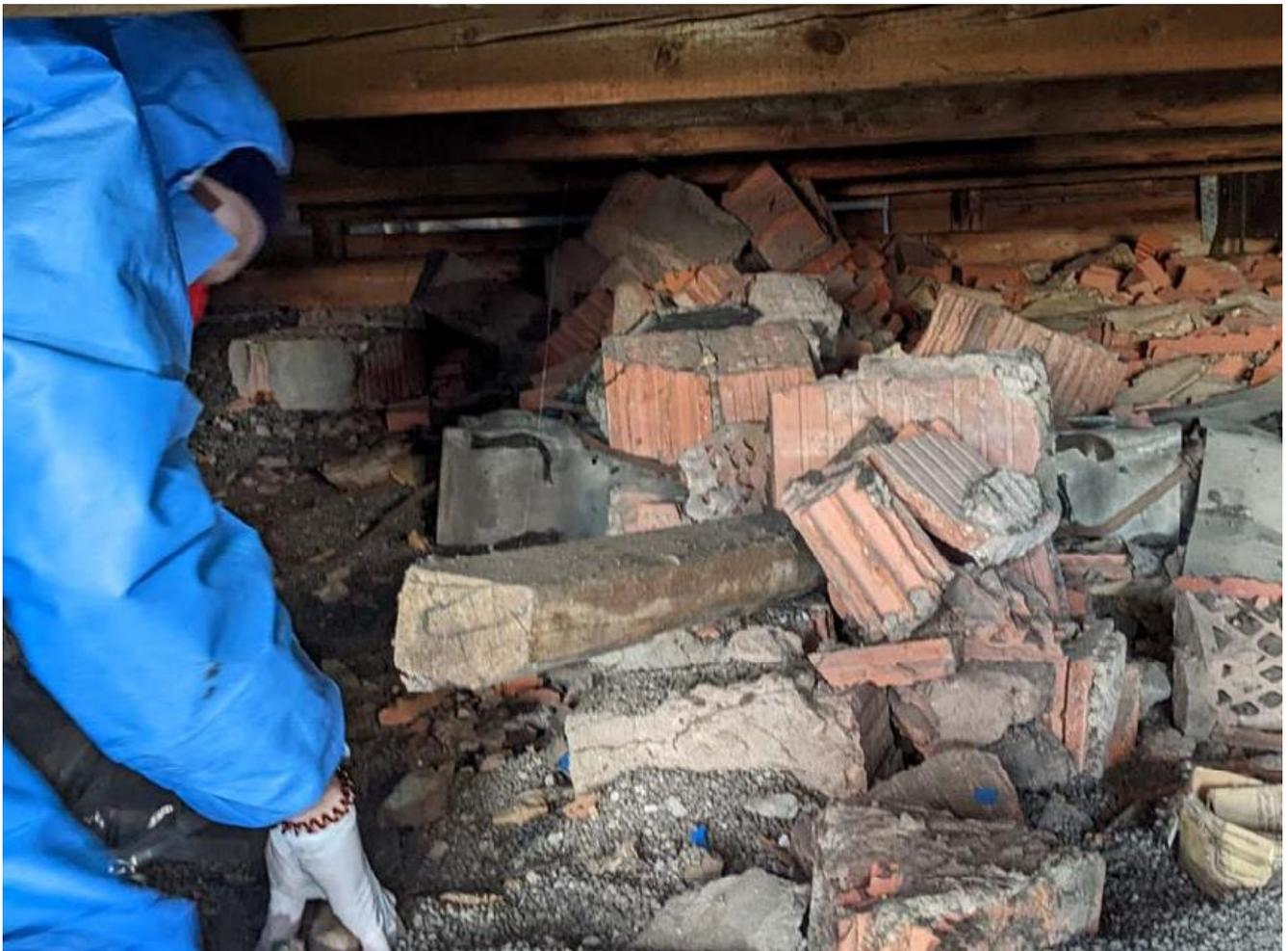
*Abb. 2: Ablagerung umfangreicher schadstoffhaltiger Bauschuttmassen auf dem Hauptdach*
