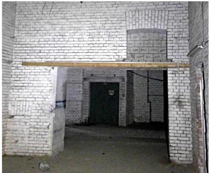
Abb. 7: Horizontaler Abriss des Deckenaufagers über dem 2. OG (o. li.), Deckendurchbruch im Zuge der Nutzung durch das Großversandhaus Quelle (o. re.), Riss in den radialen Wänden (u. li.), wilder Durchbruch im Sockelgeschoss ohne ausreichenden Sturz/ Unterzug (u. re.)
