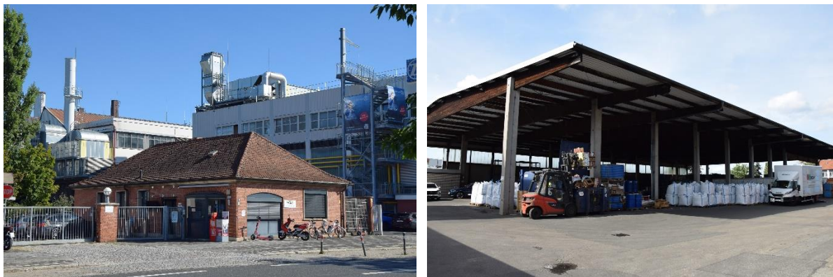
Abb. 3: Charakter als Industriegebiet (li.), Betriebsdach zur Installation PV-Anlage (re.), Quelle: Herwarth + Holz
